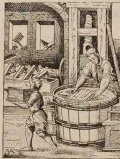
Fig. 22 — Como era feito o papel à mão. (Vê-se ao fundo, à esquerda, o tanque com os pilões que trituram os trapos; a direita a prensa; na frente a tina onde o operario imerge a fôrma, e o menino transportando uma pilha de papel entre fêltros e tábuas).
