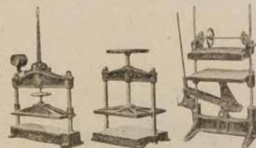
Fig. 53 -- 1.º Prensa de alavanca. -- 2.º Prensa de mesa. -- 3.º Prensa de joelho.
